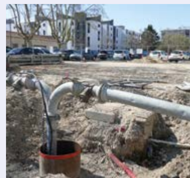
Les travaux place Kellermann
