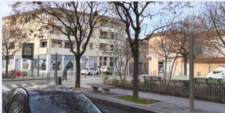
Photo d'illustration, une fois les travaux réalisés
